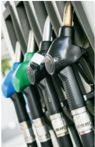
Estación de combustibles.
